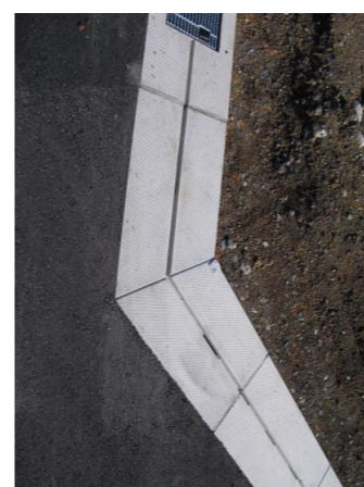
MU側溝135° 施工
