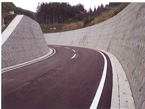
▲鹿沼・足尾線 道路改良工事
